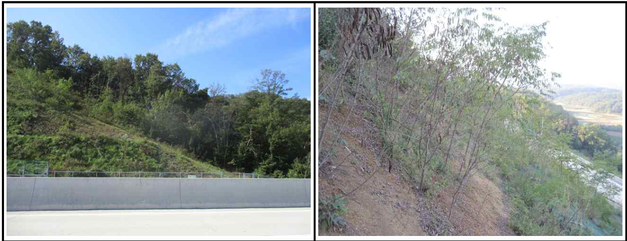
【그림 54.3.1】 상부자연사면 전경
