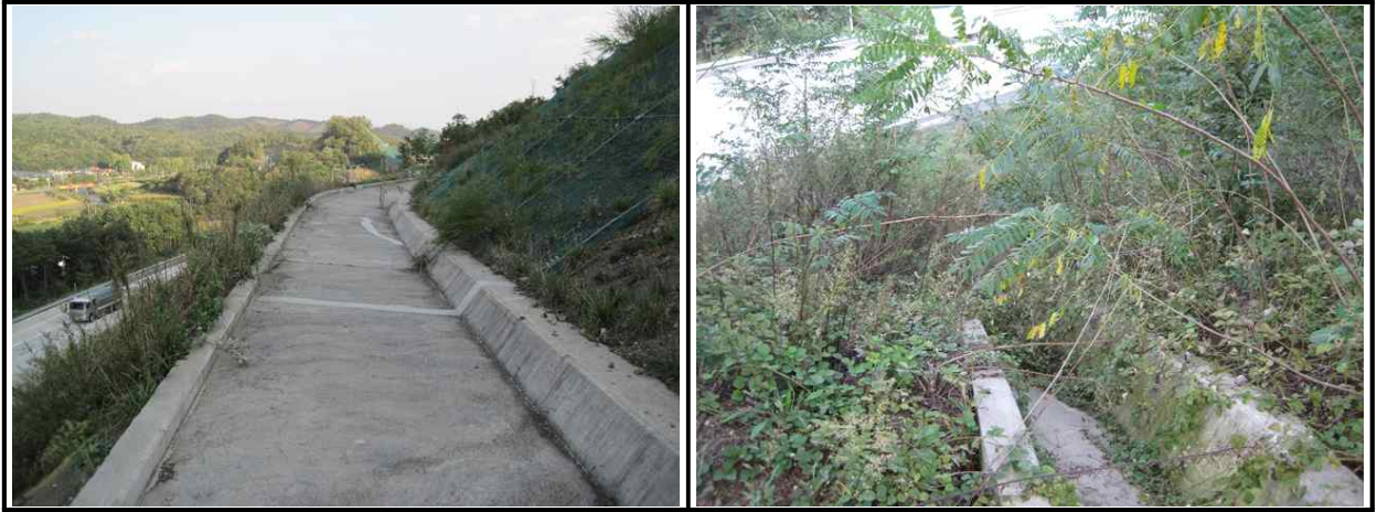
【그림 54.3.3】 배수시설 전경
